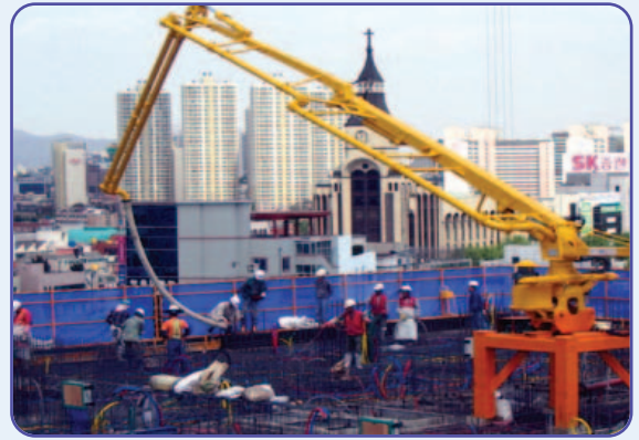
펌프카 작업 현장
